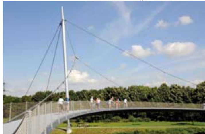
Grimbergbrücke, Fuß- und Radwegebrücke über den Rhein-Herne-Kanal, Gelsenkirchen
