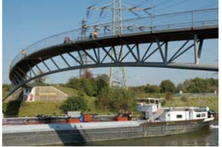
Brücke Ripshorst, Fuß- und Radwegebrücke über den Rhein-Herne-Kanal bei Oberhausen
