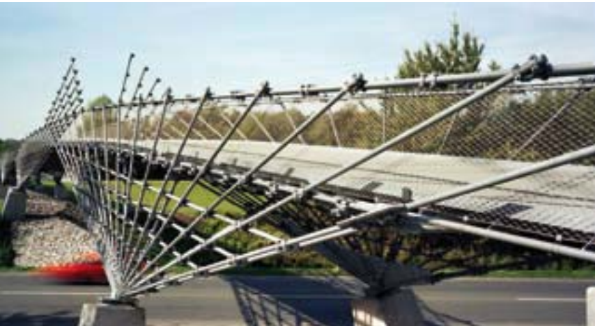
Mechtenberg-Brücke, Fuß- und Radwegebrücke im Landschaftspark Mechtenberg, Gelsenkirchen
