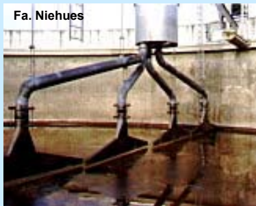
Saugräumung im Rundbecken
