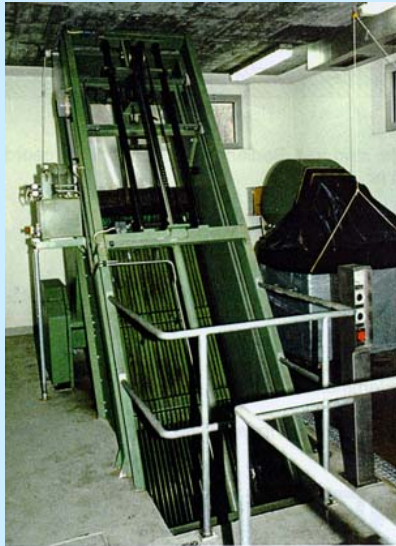
Greif- bzw. Umlaufrechen (DIN 19554 T.1)
