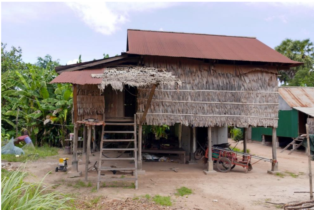
Abb. 3: Typisches kleines Haus einer ärmeren Familie, da mehrheitlich aus Palmblättern errichtet; wg. der Überflutungen während der Regenzeit auf Pfählen gegründet.
