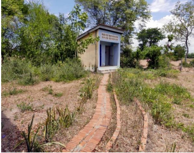
Abb. 8: In dieser Schule wurde der Versuch seitens des SSC unternommen, den Weg von den Klassenblöcken zu einer Latrine für die Regenzeit gangbar zu machen. Für Kinder im Rollstuhl ist diese Lösung unzureichend, zumal am Ende zwei Stufen zu erklimmen sind.
